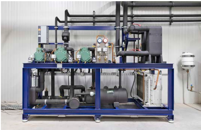
CO 2 -Tiefkälteanlage für einen Tiefkühlagerraum
