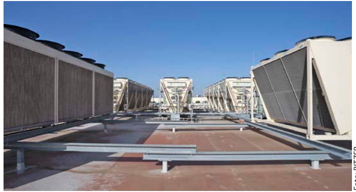
Verflüssiger und Rückkühler auf dem Dach der Kältezentrale
