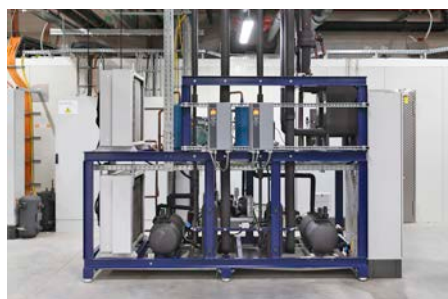
CO 2 -Tiefkälteanlage zur Scherbeneisbereitung
